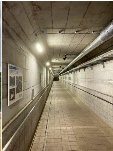
エレベーターへの通路
